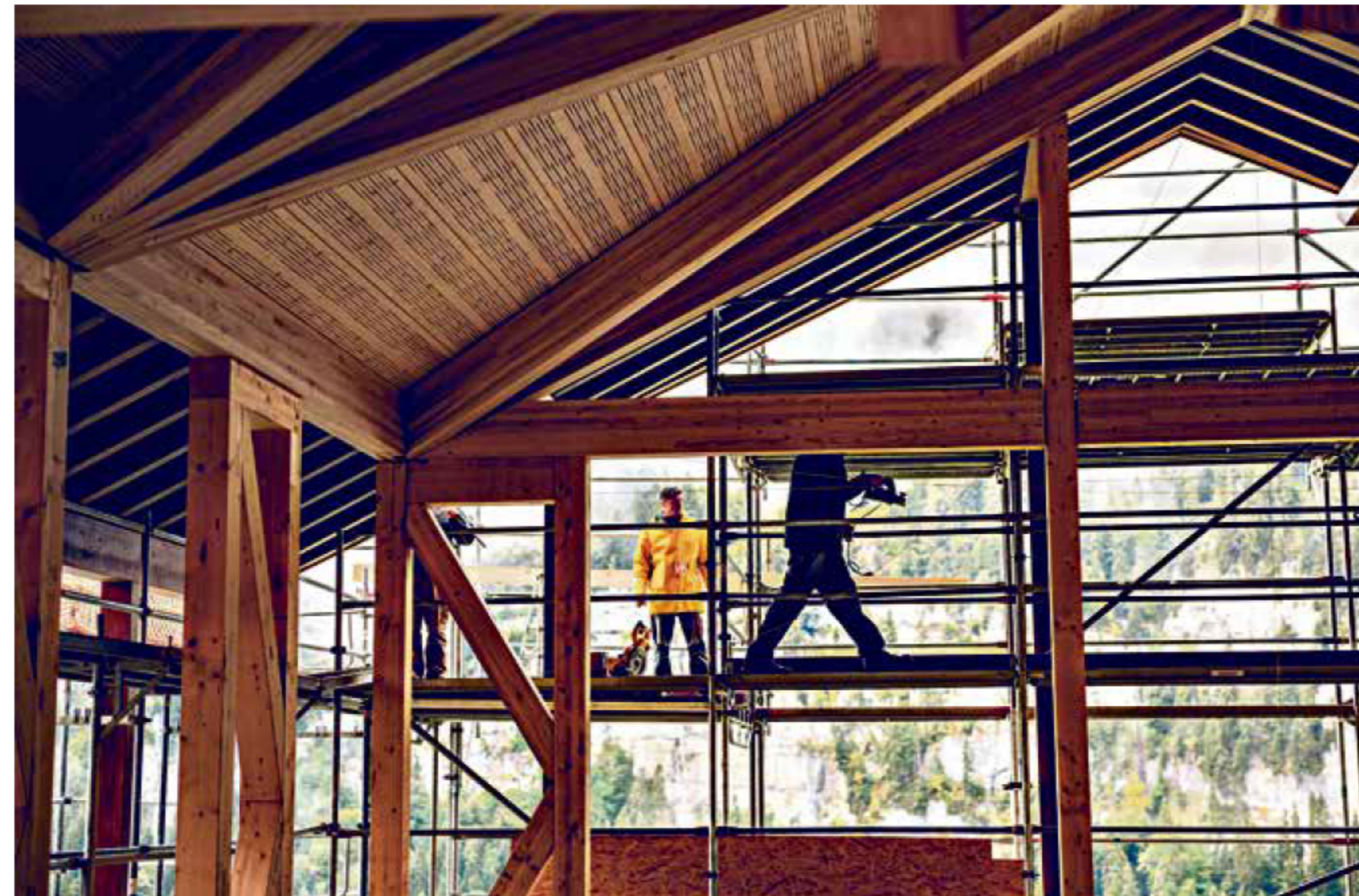
Le chantier actuel du bureau de l'entreprise genevoise est un futur centre de yoga à Champéry, en Valais. (DAVID WAGNIERES POUR LE TEMPS)
